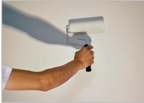
Step 1 - Start applying Primus Sabbia
